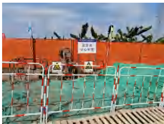
施工现场泥浆池
