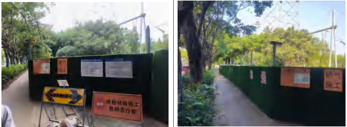
施工噪声防治围板
