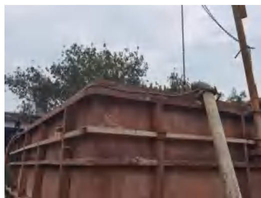
施工现场泥浆罐
