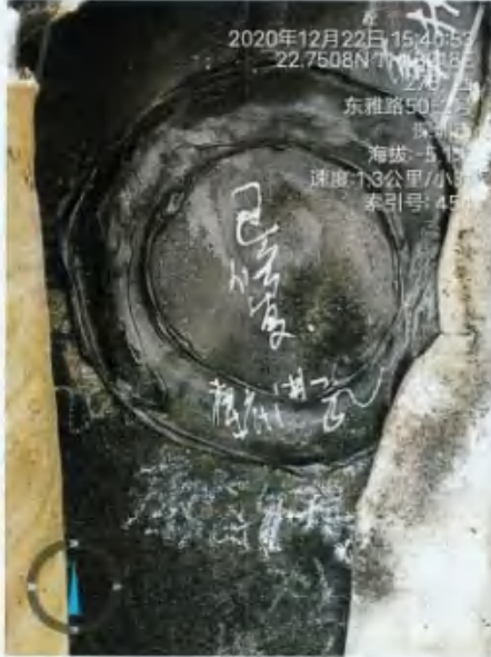
图 10.1 修补破损处图片
