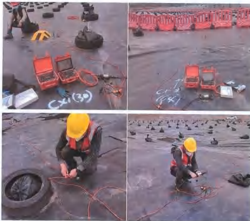
图 3.1-2 ERT 渗漏污染范围探测现场照片
