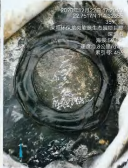
图 10.2 修补破损处图片
