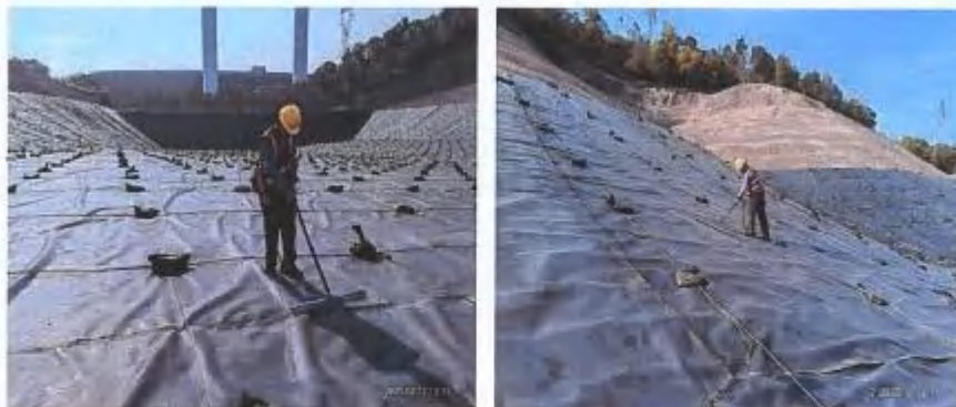
图 3.2-2 电火花法渗漏破损探测现场照片
