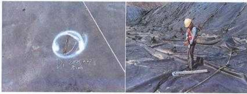
图 4.2-1 破损孔洞修补及复测
