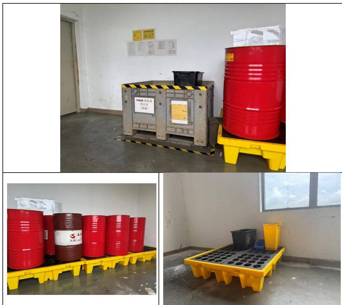
图 20 现有危废暂存间图片
