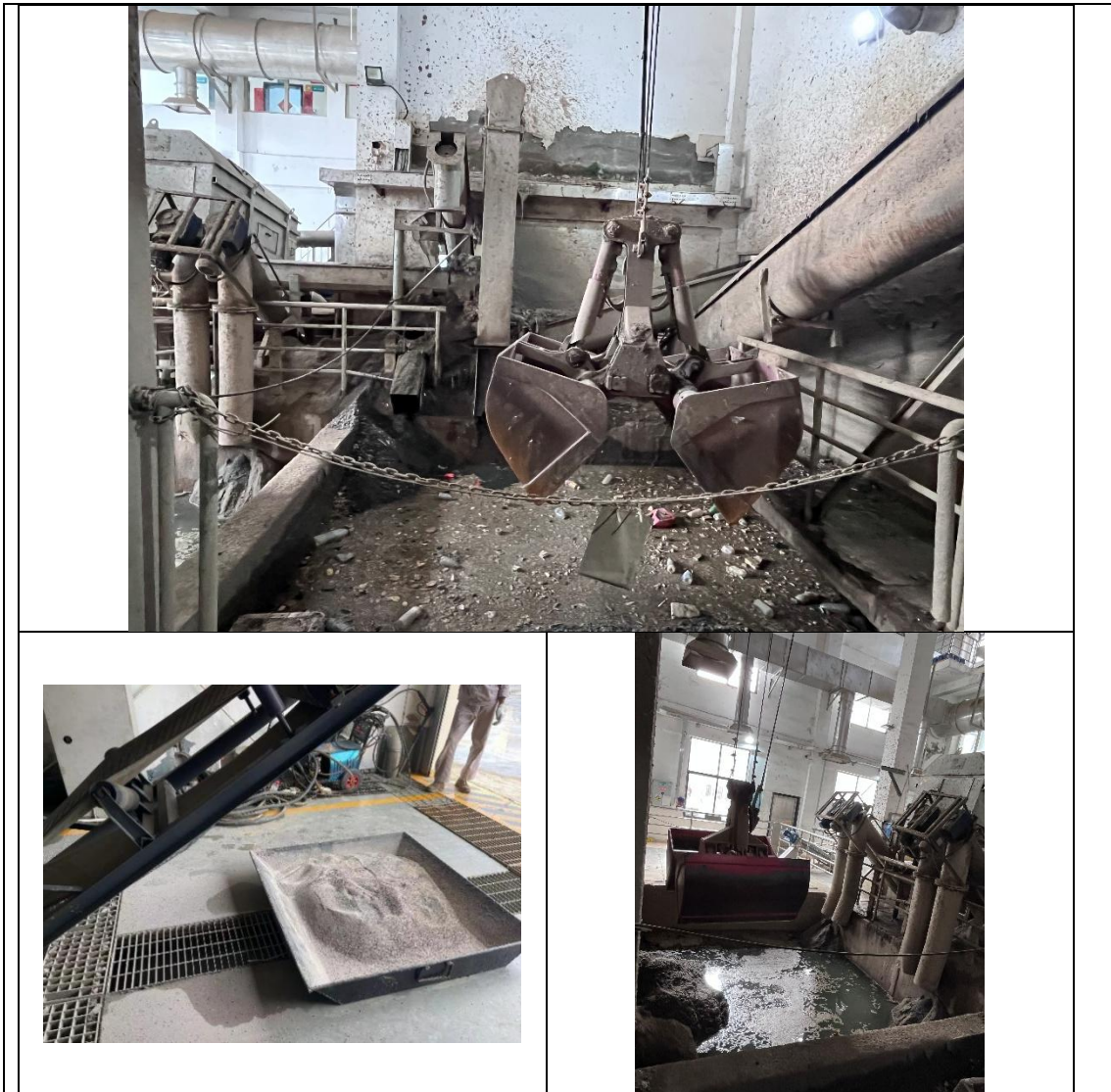
图 15 一般固废暂存场所图片
