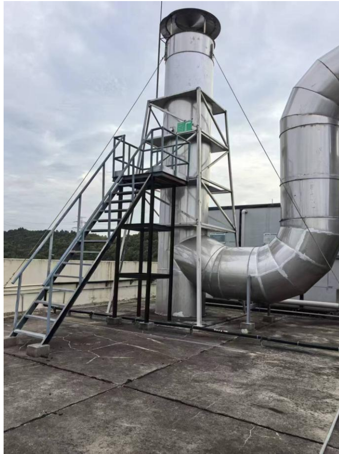
图 13 废气有组织排放口照片
