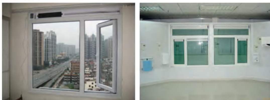
图 6-4 隔声窗应用实例
