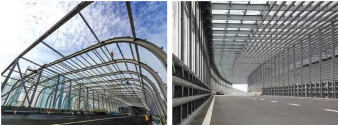
图 6-3 全封闭式声屏障工程示例图
