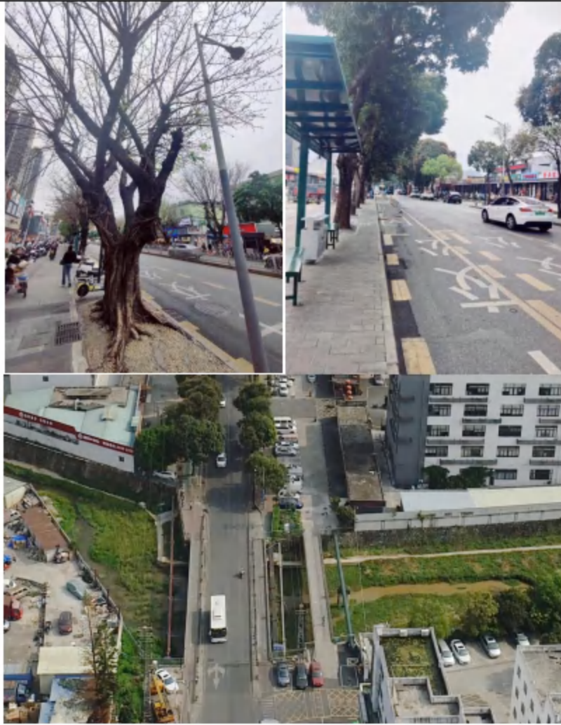
图 3-3 项目道路现状照片
