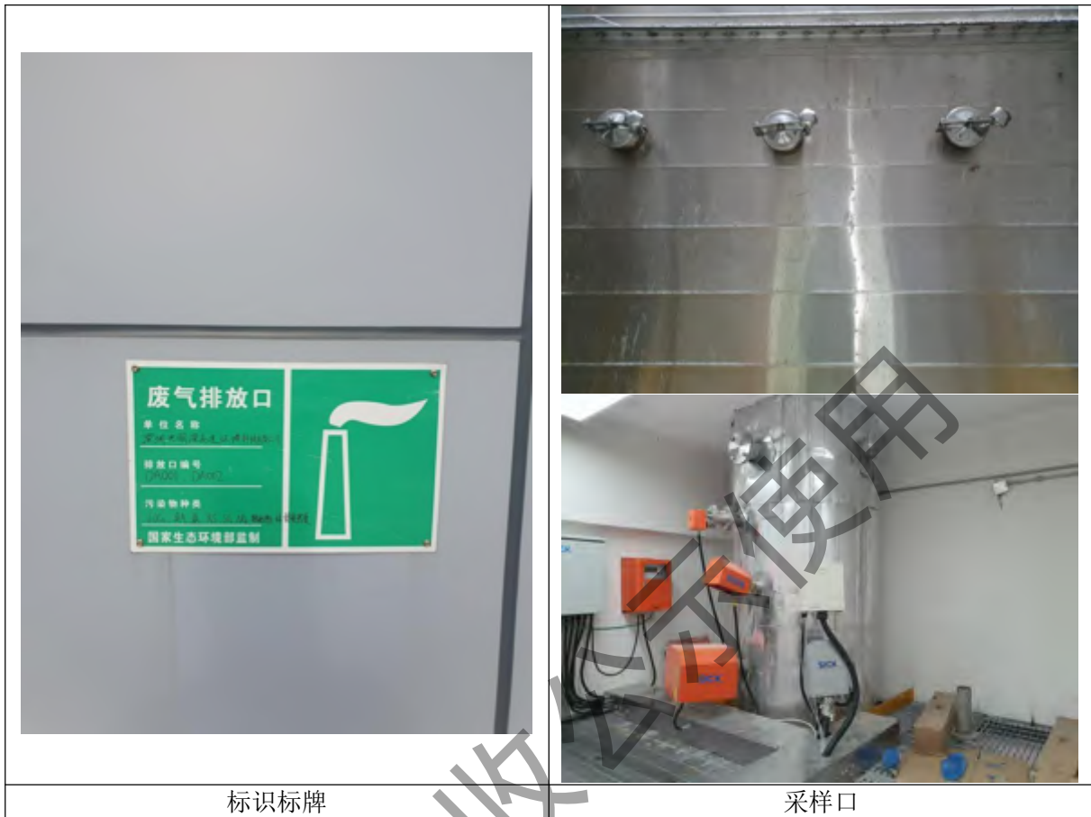
图 4.3-3 项目废气处理设施、排放口、采样平台现场照片
