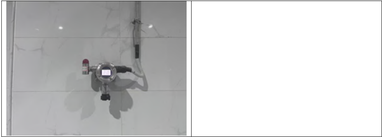
图 4.1-9 废气报警装置
