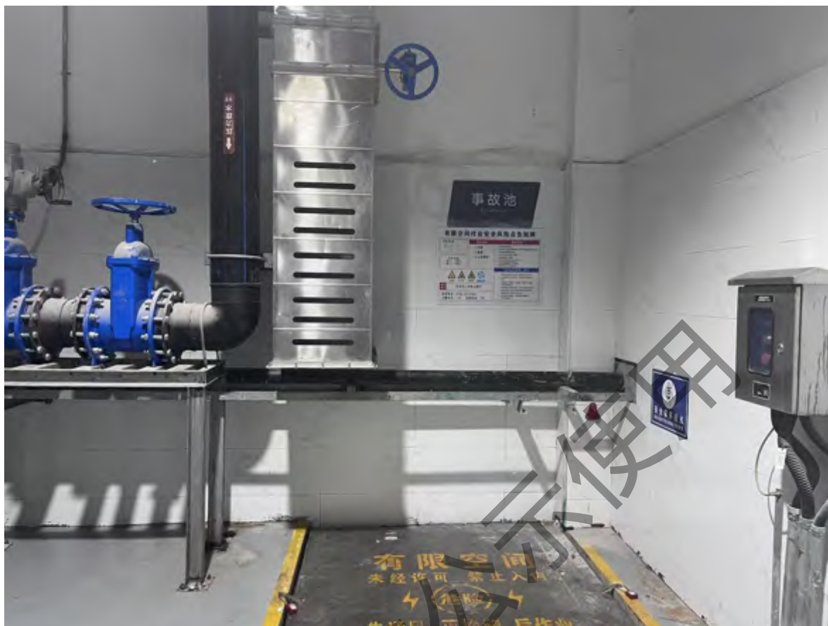
图 4.1-8 事故废水收集池
